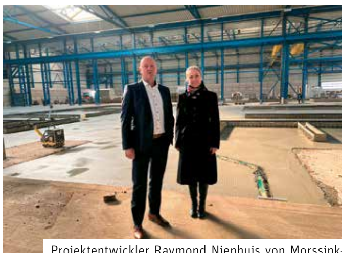
Projektentwickler Raymond Nienhuis von Morssinkhof Plastics führt Bürgermeisterin Nadine Stitterich über die Baustelle
